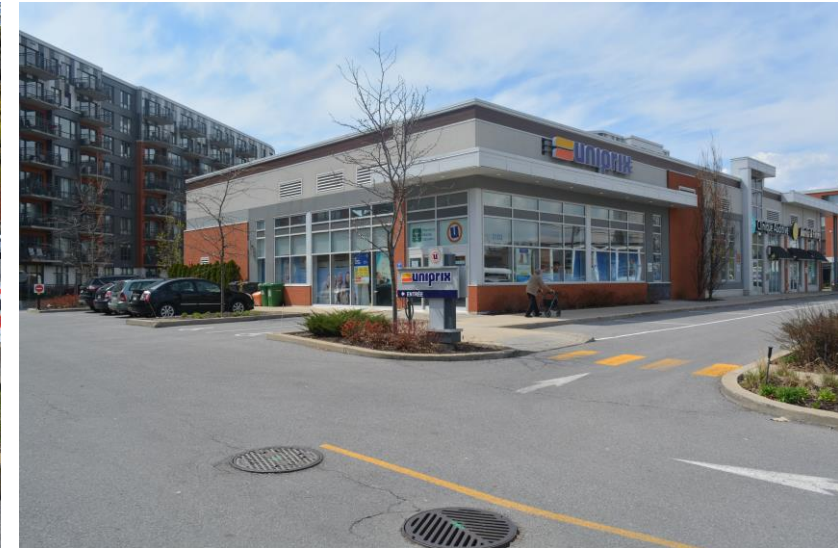
Résidence Le Savignon à Montréal, offre des commerces dans son espace immédiat
